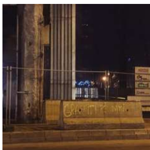
Img. 8 Semnalizare agresivă șantier abandonat, ce blochează întreg trotuarul est al străzii Armand Călinescu în proximitatea Bisericii Armenești.
