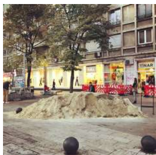
Img. 7 Șantier neamenajat – depozitare materiale construcției în Piața Romană.
