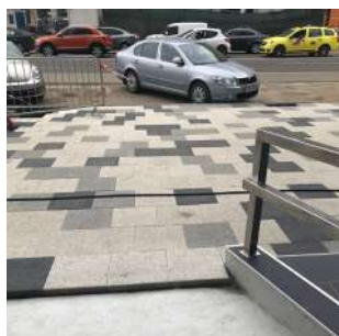
Img. 10 Reamenajarea recentă a trotuarului Bulevardul Decebal, nerespectând cota anterioară și racordul cu rampa de acces pentru persoanele cu dizabilități.
